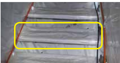
階段の養生に
