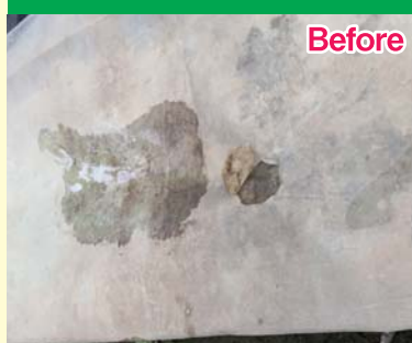
フィルムダクトの補修
