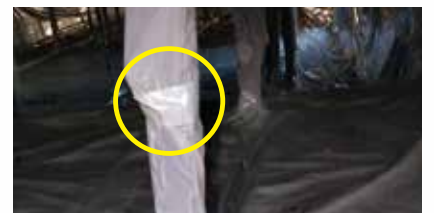
柱・ポールの養生に
